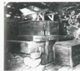
108. Saint-Germain-Lavalp. La Combe. Moulin à eau sur le ruisseau de Serignac; voir l'histoire : le massif des meules et la hache à farine.
