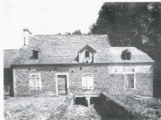
551. Lanusse-Pujoulet. Moulin à eau. Éléments antérieurs.
