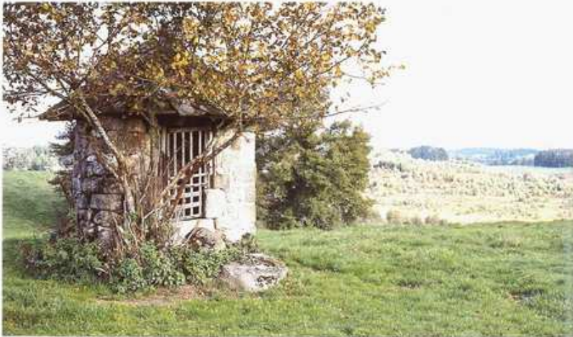
95. Moustier-Ventadour. Le Theil. Puits couvert de dalles de schiste (lauzes).
