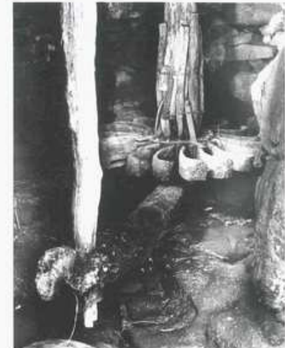
109. Pérels-sur-Vézère. Varidras. Moulin à eau sur le ruisseau d'Art; roue à cuillers. La trompeur est visible au premier plan.
