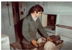
Opérateur sur la machine Polte (pour les 57mm, afin de séparer l'obus de la douille). © Collection particulière.
