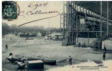
Cale de construction de l'Arsenal, carte postale, 1904. © Fonds numérique Michel Basse, Archives municipales de Rochefort.
