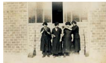
Ouvrières de l'atelier de fabrication d'allumettes, en 1927. © Fonds numérique Arlette Moreau, Archives municipales de Rochefort.
