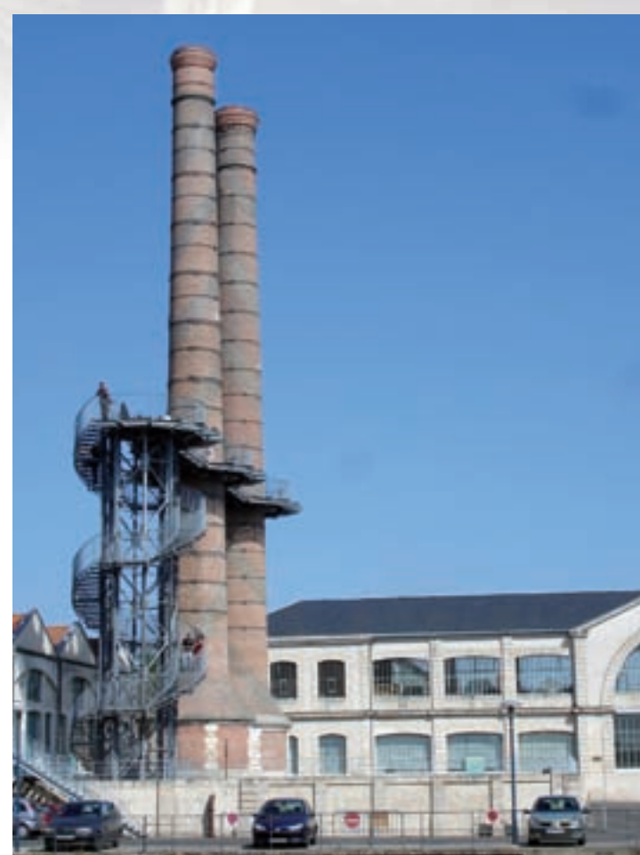
Les cheminées de la Manu.
