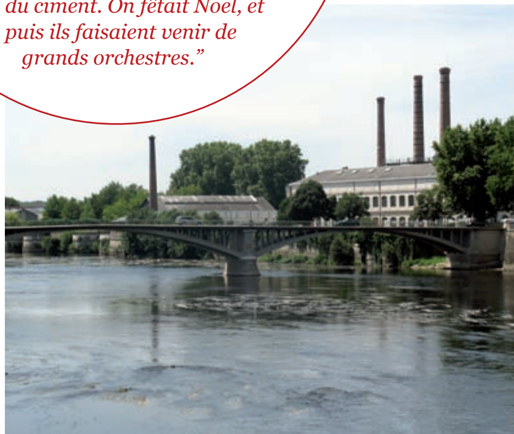
Le pont Camille-de-Hogues en béton armé, édifié en 1899 pour faciliter le passage des manuchards habitant rive droite, a souvent été appelé “le pont de la Manu”.
