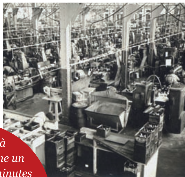
Bâtiment 139, l’atelier de fabrications mécaniques, vers 1960. © Collection du ministère de la Défense, archives de l’armement
