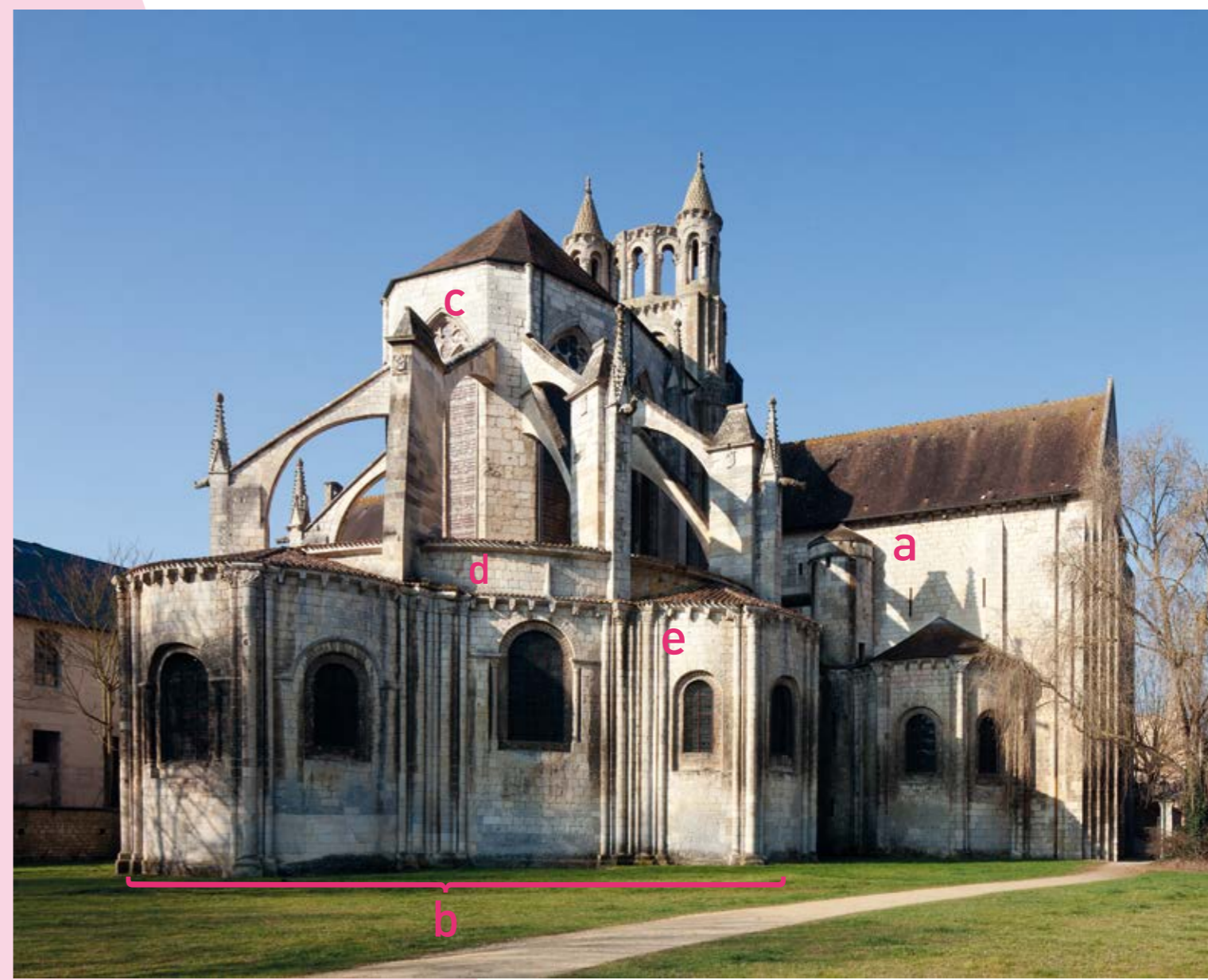
▲ Église Saint-Jean-de-Montierneuf, Poitiers (Vienne). Cette vue montre le transept (a) et le chœur (b) de l'église, composés d'une abside (c), d'un déambulatoire (d) avec absidioles (e). À l'époque gothique, l'abside a été rehaussée, percée de hautes fenêtres et confortée d'arcs-boutants.
