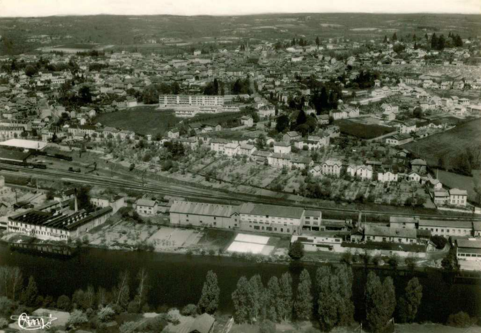
La Vienne en amont du pont Notre-Dame (vers 1960)
