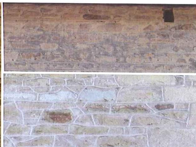
Moellons maçonnés marquage des assises au fer dans le joint. Décor des joints rubanés.
