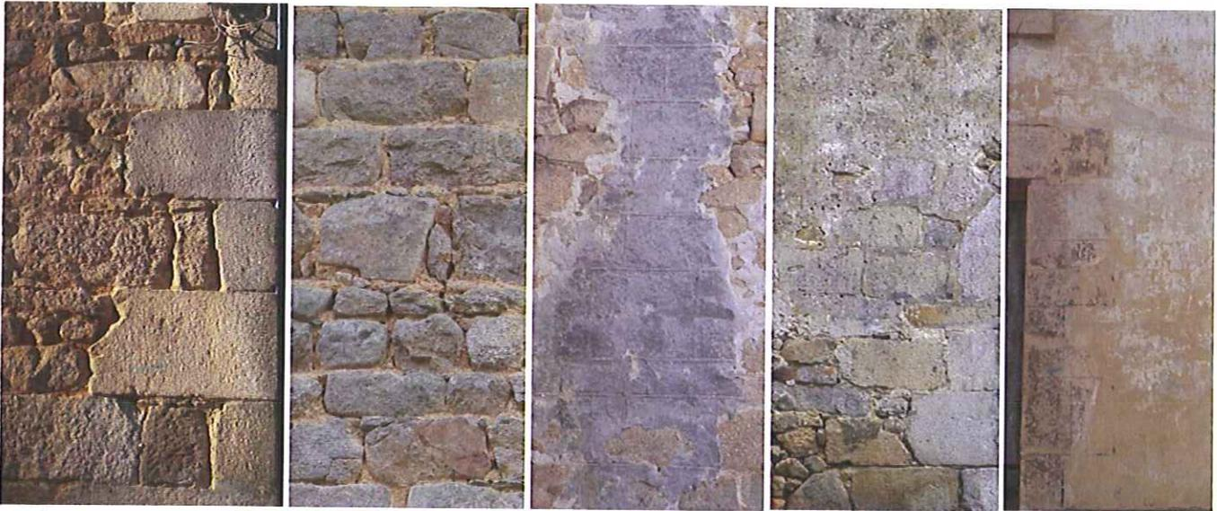
Moellons, chaînage, joints sans tuf. Joints au tuf.
