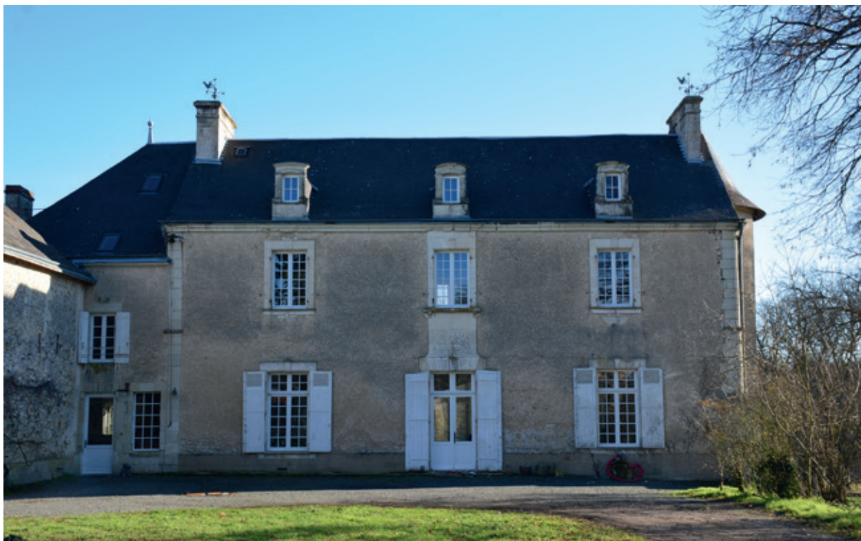
L'élévation nord-ouest du logis de la Font.
