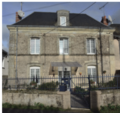
Maison de la seconde moitié du 19 e siècle, au n° 19 de la rue de l'Étoile.
