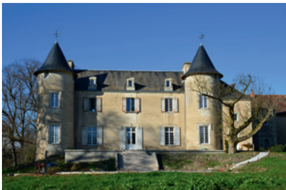
L'élevation sud-est du logis de la Font. Les deux tours d'angles sont construites entre la fin du 15 e et le début du 16 e siècle.
