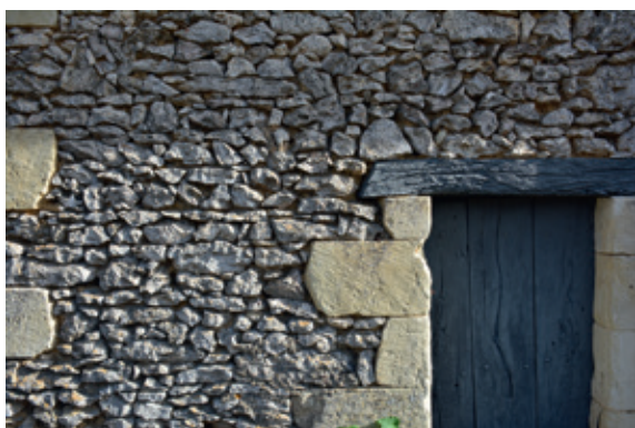
Moellons de calcaire durs employés dans une maçonnerie.
