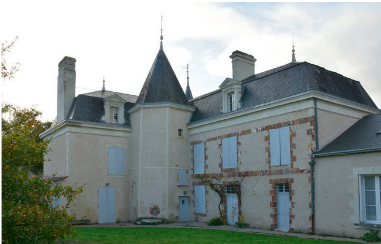
L'élévation sud-est du logis de la Gabillère. L'aile à gauche de la tour d'escalier date du 18 e siècle, alors que celle de droite fut reconstruite au 19 e siècle.
