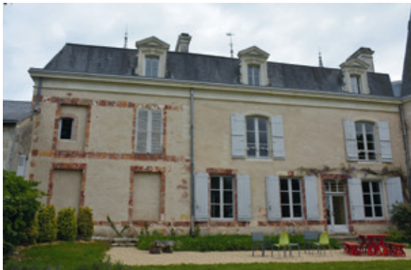
L'élévation nord-ouest du logis de la Gabillère.
