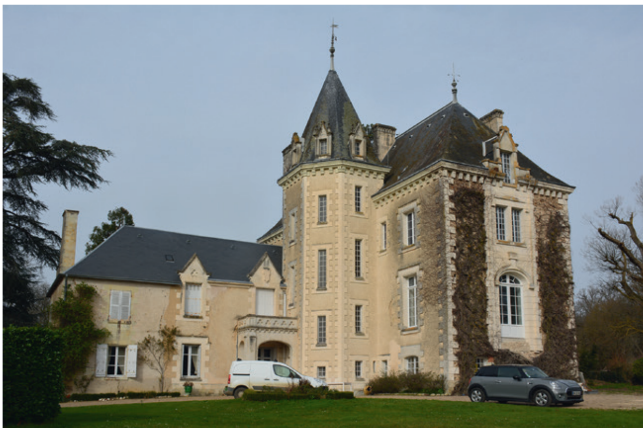
Le logis du Soucy, vu depuis l'est.
