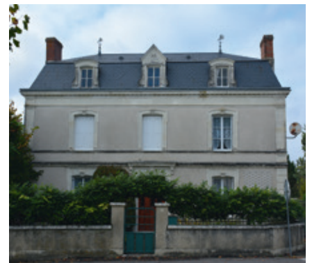
Maison au n° 9 de la rue Raymond d'Argence, construite en 1881.
