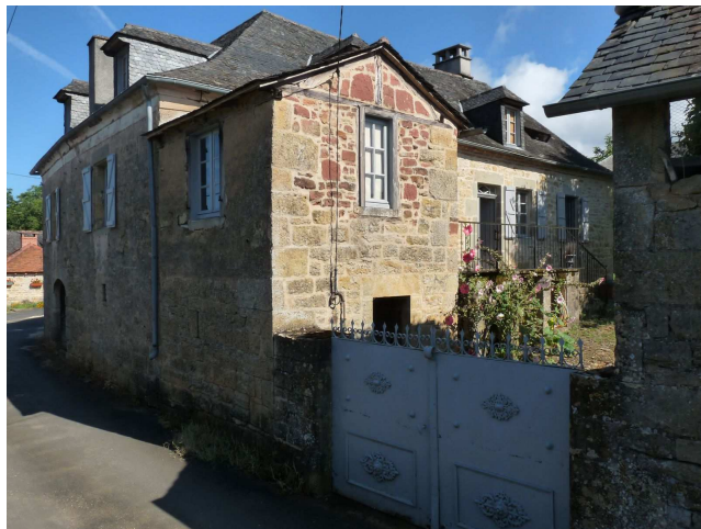
Sabazot : couverture en ardoise, les pentes s'adouissent
