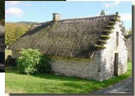
Exemple de couverture de chaume
