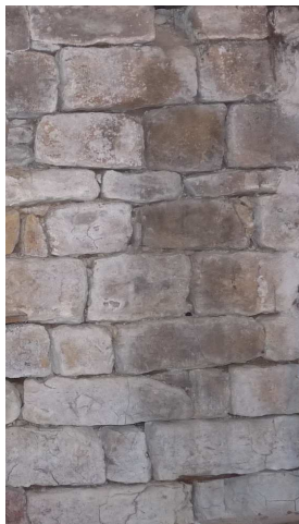
Le bourg : détail d'un appareil en moellon de calcaire (16 e siècle)
