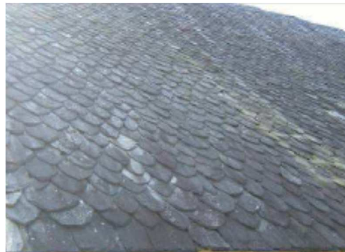
Les treilles : détail d'une couverture d'ardoises en écaille
