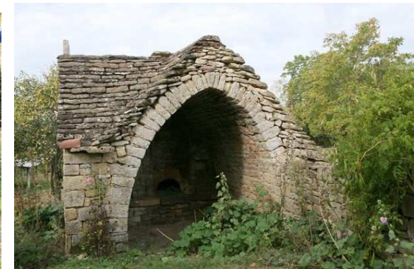
Les Treilles : four coiffé d'un toit en double bâtière, couvert de lauzes (4 e quart 16 e siècle)
