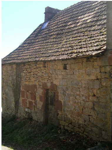
Lafont : maçonnerie en blocage de moellons assisés (15 e -16 e siècles)
