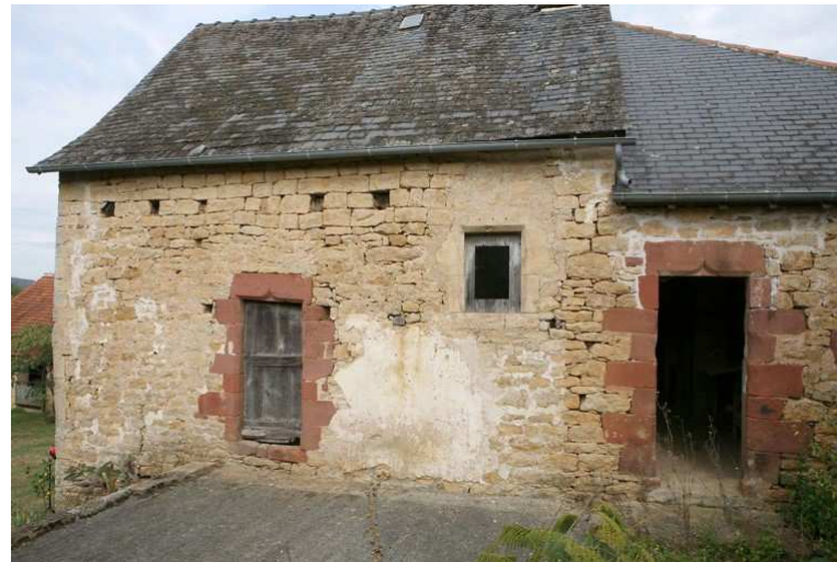
Les treilles : maçonnerie en blocage de moellons recouverte à l'origine d'un enduit à la chaux (4 e quart 16 e siècle)
