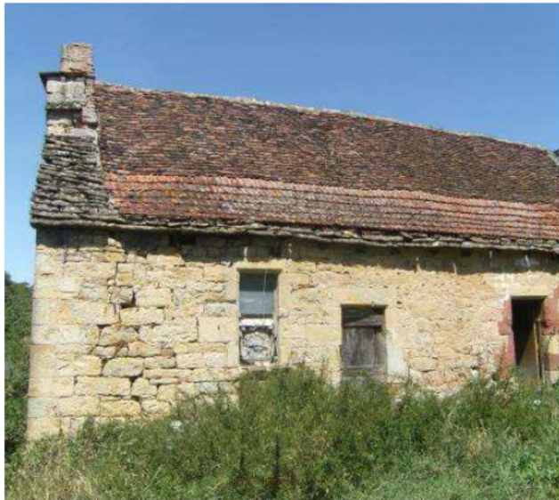
Sabazot : rives et égouts de toit couverts de lauzes ; charpente couverte de tuiles plates et de tuiles mécaniques
